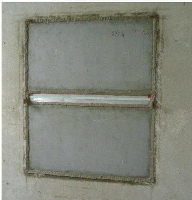
Figura 3 Foto di un elemento montato (eseguite dal Centro ift per l'isolamento acustico)
